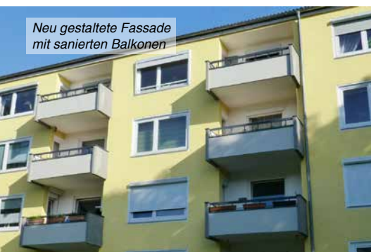
Sanierung eines hälftig auskragenden Balkons
