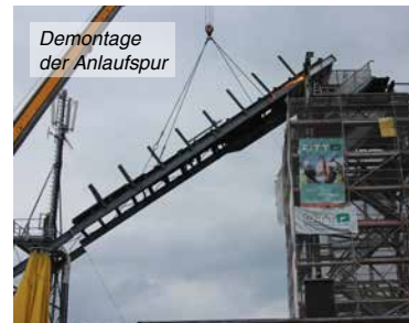
Die Anlaufspur (ca. 9000 kg!) schwebt zur Verschrottung Richtung Boden.
